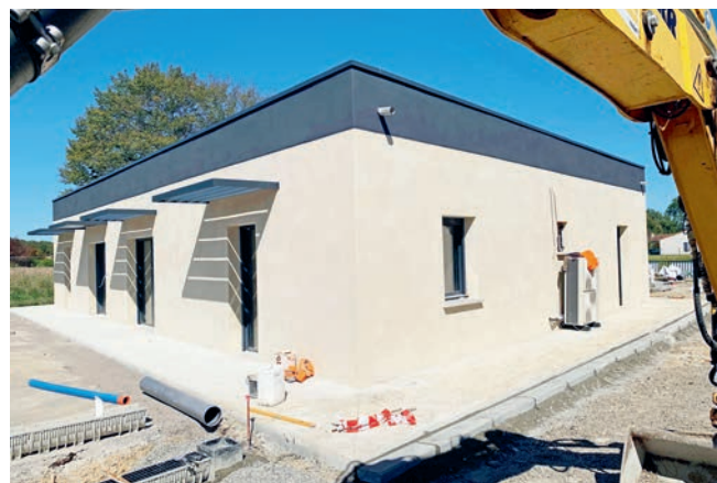
Vue de la maison médicale depuis la nouvelle Impasse des Ateliers
